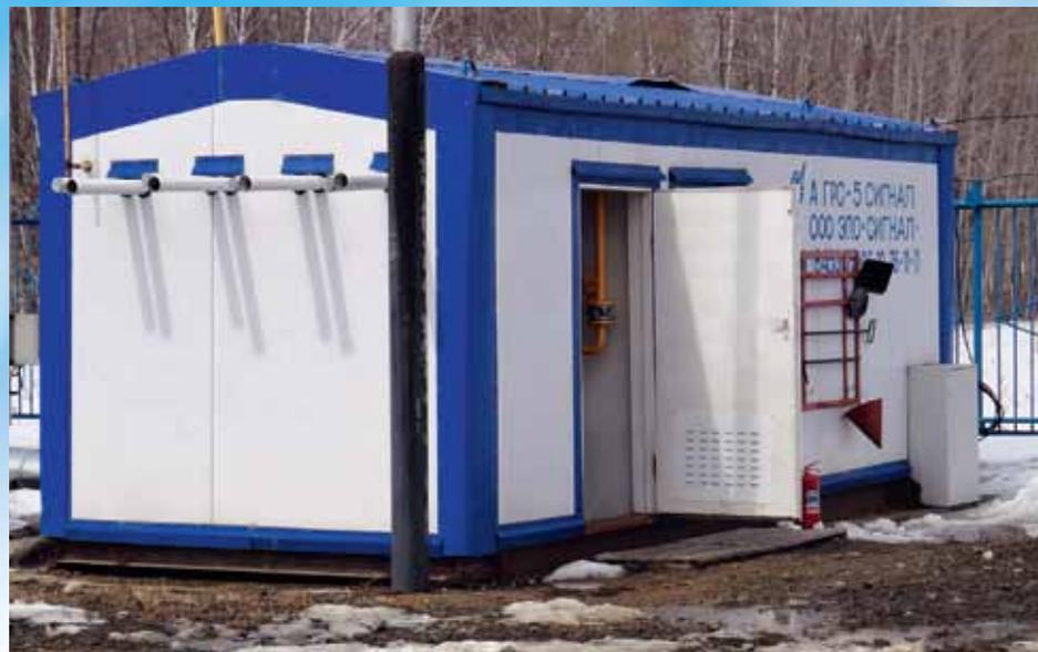
Питание электрооборудования АГРС осуществляется от сети переменного тока 220 В, частотой 50 Гц. Имеется резервный источник питания постоянного тока 24 В, обеспечивающий сохранение работоспособности САУ АГРС в течение 24 часов без потери информации. Переключение нагрузки на резервное питание при отключении основного — автоматическое. Предусматривается так же автоматическая подзарядка резервных аккумуляторов.
